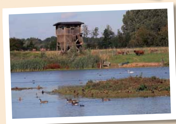
Ancien bassin de décantation à Thumeries
